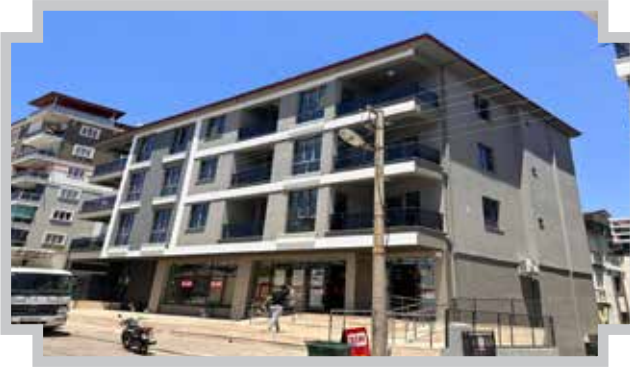
Yapı Kullanım İznine Uygun Bina
