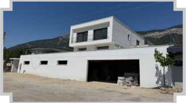
Ruhsatlı yapıya ruhsatsız olarak ilave yapı yapılmıştır.
