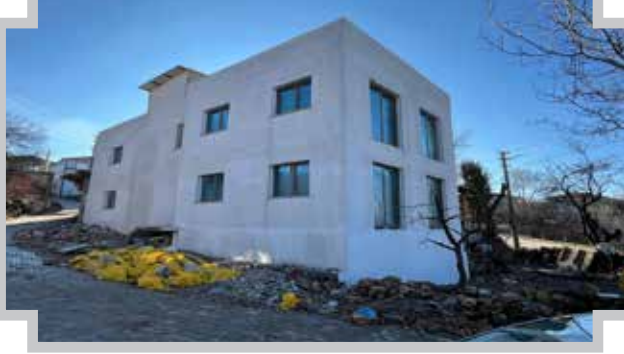
Ruhsatsız 2 katlı yapı yapıldığı tespit edilmiştir.
