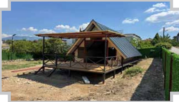
Ruhsatsız 1 katlı yapı yapıldığı tespit edilmiştir.
